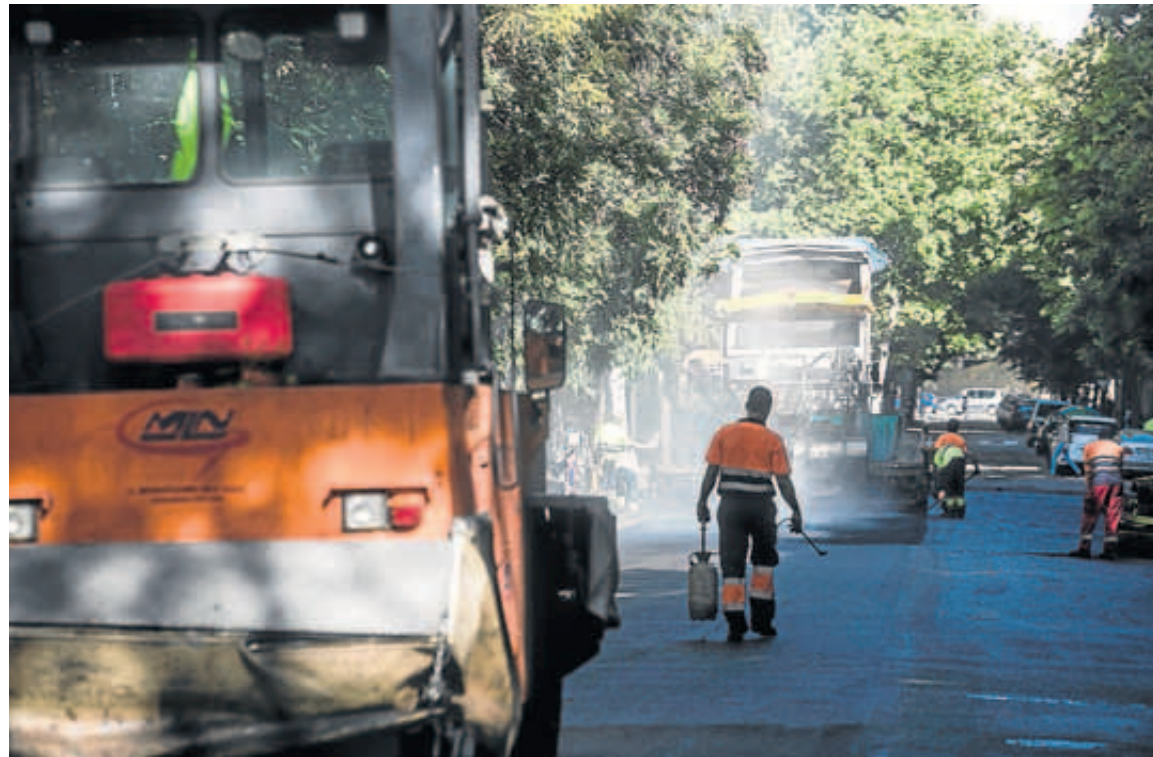
Los trabajos de fresado, ayer por la tarde en un tramo de la calle de Joaquín Costa. ASIER ALCORTA
